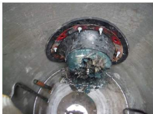
立坑内の到達状況
