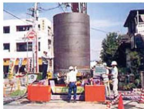
先端ケーシング建込
