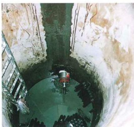
掘削ヘッド到達状況
