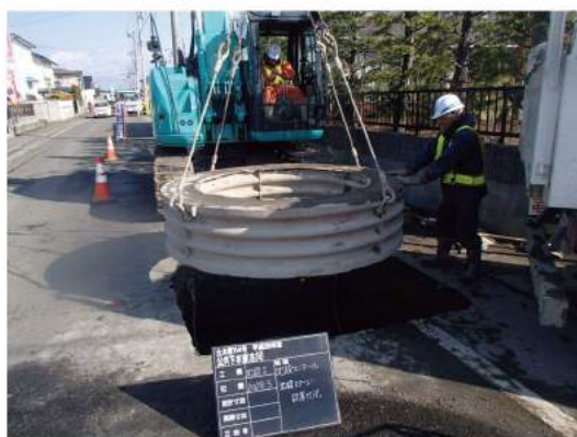
沈設ステージ設置
