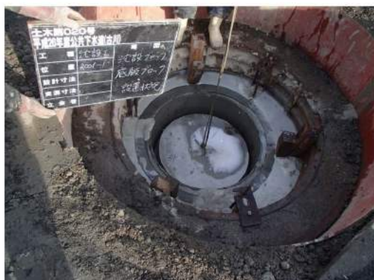
底盤ブロック設置
