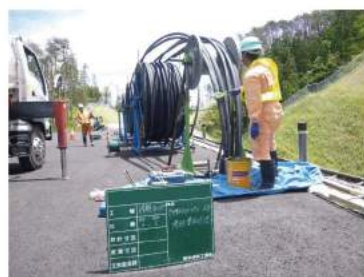
牽引状況（発進側）
