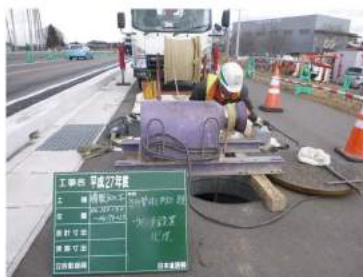
牽引状況（到達側）
