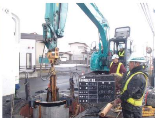
ジャッキ圧入・クラムシェル掘削
